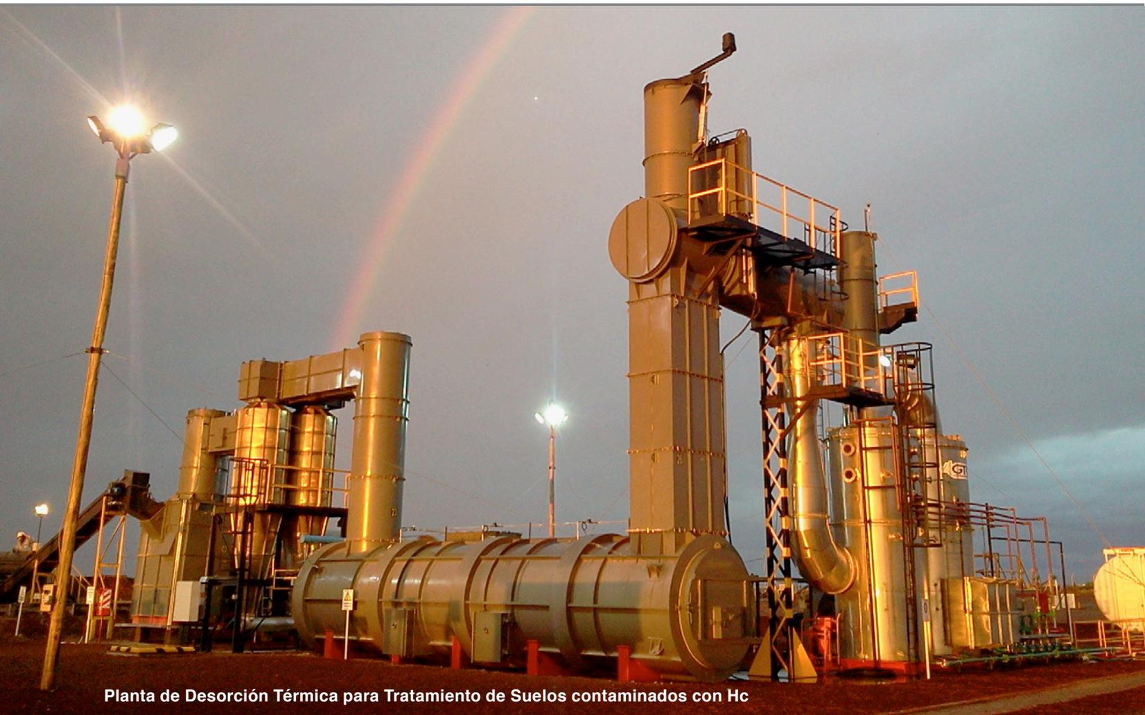
Planta de Desorción Térmica para Tratamiento de Suelos contaminados con Hc
