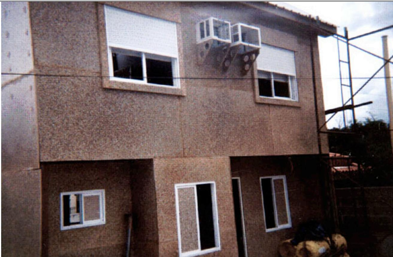
*La compresión a través del calor de todos los elementos que forman parte del envase de cartón de Tetra Pak tiene como resultado la formación de un resistente aglomerado que resulta útil para la construcción de objetos e inclusive de viviendas.*
